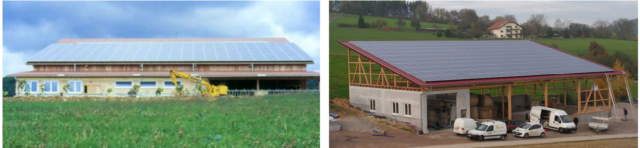
Zwei der bürgerfinanzierten Photovoltaikanlagen in Mauenheim
