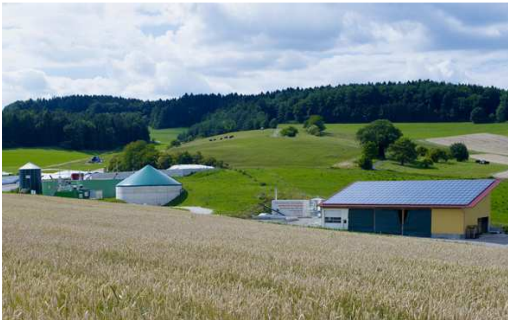
Biogasanlage (im Bau)
