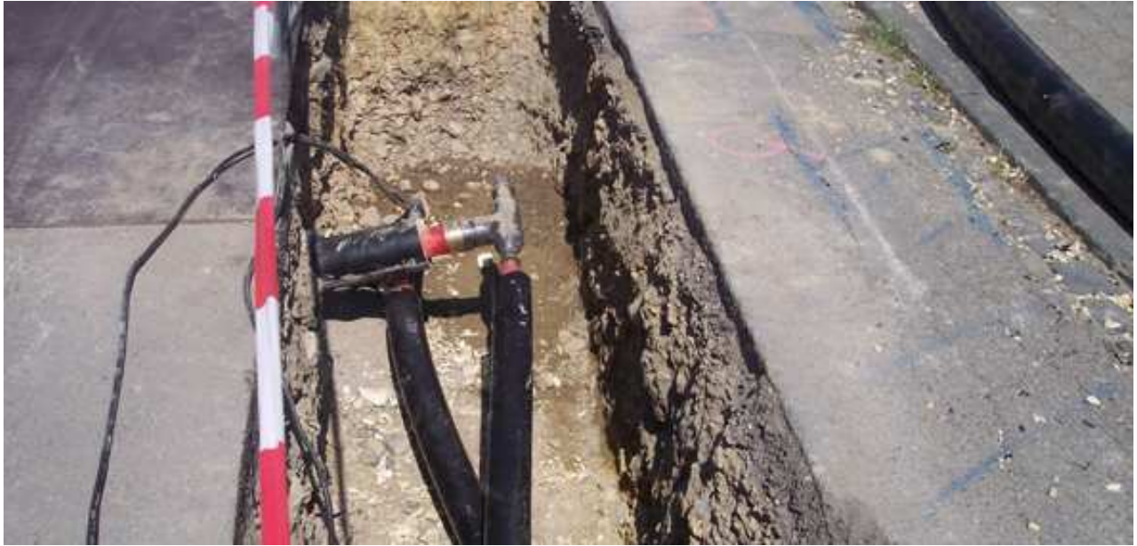
Nahwärmeleitung mit T-Stück im offenen Graben
